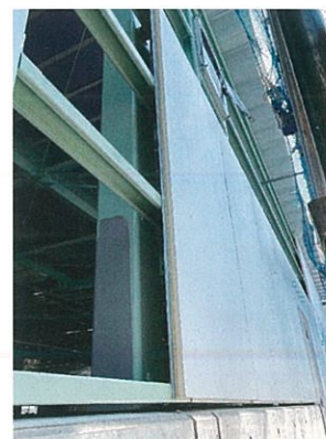
室外側施工状況
