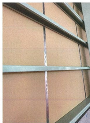
室内側施工状況
