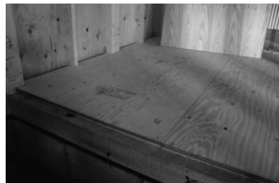
床合板による気流止め
