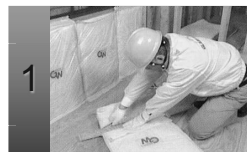
1 現場寸法に合わせて、長さや幅を詰めて充填します。
