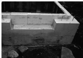
① 玄関廻りの基礎内側断熱
