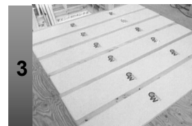
3 床断熱の施工完了後、床合板を施工します。
