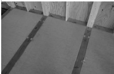
土台・大引間にボード状繊維系断熱材を充填
