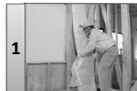
1 繊維系断熱材についている防湿フィルムを筋交い部の位置まで貼ります。
