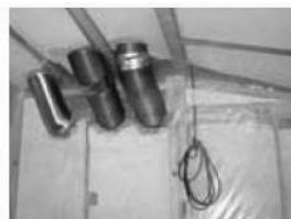
設備配管やコンセントボックス、スイッチボックスなどの取り付け部分は、すき間が出来ないように断熱材の端材を詰め込み、防湿フィルムとの取り付け部分もすき間が出来ないように気密テープで留めつけます。
