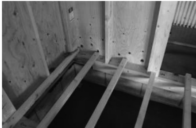
床と外壁との取合い部の隙間にボード状繊維系断熱材の端材を充填
