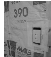
設備配管やコンセントボックス、スイッチボックスなどの取り付け部分は、すき間が出来ないように断熱材の端材を詰め込み、防湿フィルムとの取り付け部分もすき間が出来ないように気密テープで留めつけます。
