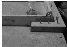
② 玄関土間施工後
