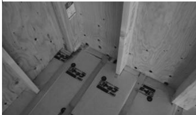
床と外壁との取合い部の隙間にボード状繊維系断熱材の端材を充填
