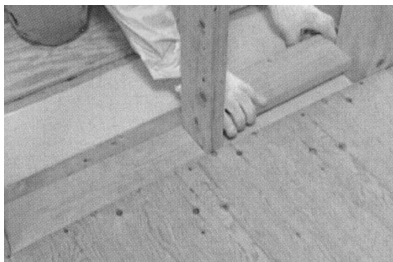
乾燥木材による気流止め
