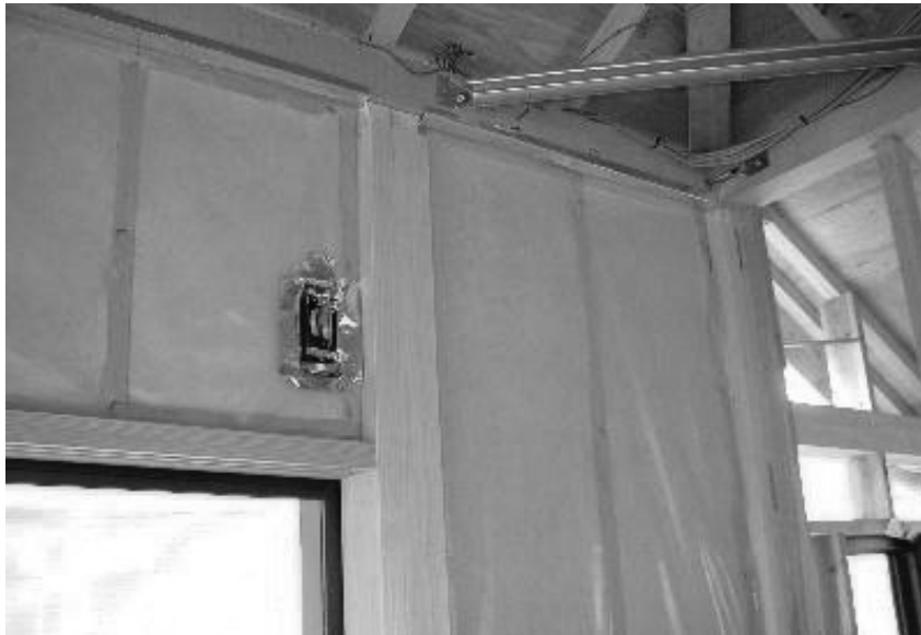
別張り防湿シートを受け材に留めつけた施工例
