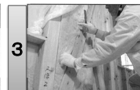
3 筋交いのところで断熱材に切り込みを入れ、押込まれている断熱材を筋交いと面になるようにします。
