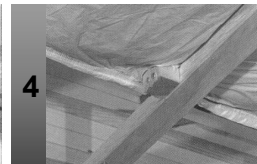
4 野縁の下に、別張り防湿フィルムを施工します。
