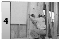
4 はがした防湿フィルムをかぶせ直してタッカー釘で防湿フィルムの耳を見付面に留めつけます。
