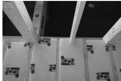
床合板による気流止め
