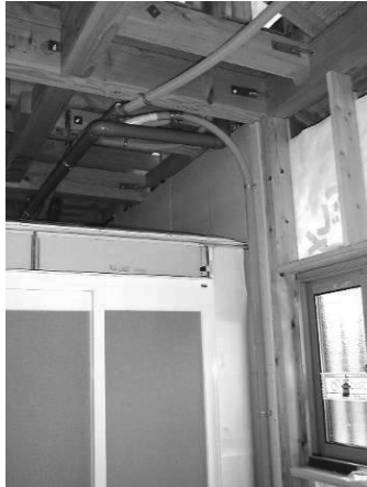
断熱・防湿施工が完了してからユニットバスを施工します。
