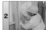
2 筋交いの裏側(屋外側)を通して断熱材を充填します。
