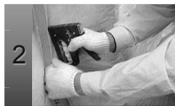
2 防湿フィルムは見附面にタッカー釘で留めつけます。
