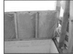
石こうボード等の面材で防湿フィルムの耳を押さえつけられない場合は、乾燥木材で押さえつけ、気密性を確保します。
