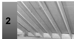
2 断熱材を施工する前に垂木間に通気層確保部材を設置します。
