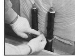
設備配管があるため石こうボード等の面材で耳かけ部分を押さえにくい部分は気密テープで留めつけます。
