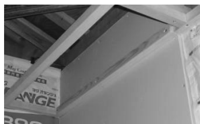
気密テープによる防湿フィルム耳かけ部分の耳押さえ(4地域以南)
