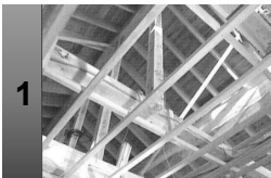
1 天井野縁を組んだあとに断熱材を野縁の上に敷き込みます。
