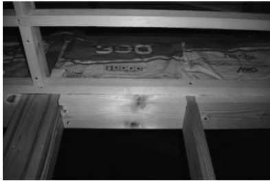
乾燥木材による気流止め
