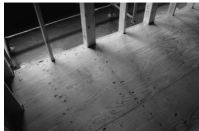
床合板による気流止め
