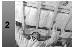
2 断熱材にすき間ができないようにしっかりと突き付けます。
