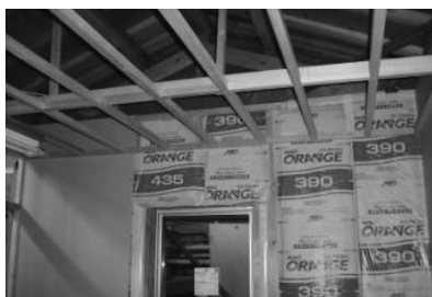
乾燥木材による防湿フィルム耳かけ部分の耳押さえ
