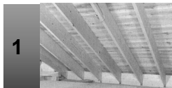
1 施工前の状態
