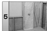
5 防湿フィルムの下端の耳は床合板に30mm以上留めつけます。
