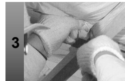
3 吊り木まわりは断熱材に切り込みを入れます。
