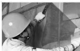
繊維系断熱材に付属の防湿フィルムの施工が困難な部分は、別張り防湿フィルムを施工します。
