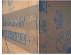
②出隅へ心かし材として面材を施工します。
